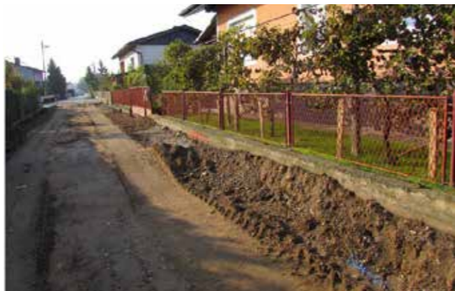
Izvršena rušitev obstoječega asfalta in zakoličena trasa obstoječega vodovoda.
