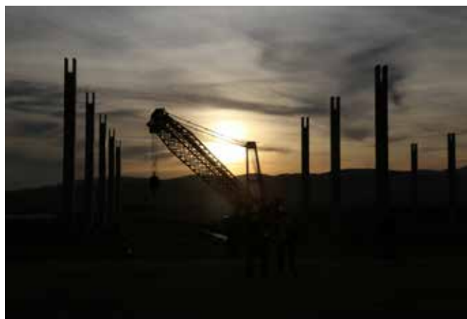
Gradbišče Magne hitro dobiva novo podobo.
