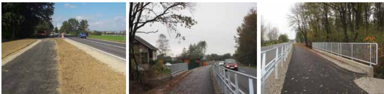
Del kolesarske steze je že asfaltiran, postavljena je varnostna ograja, lepo je utrjena tudi škarpa pred ribnikom.
