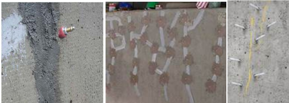
Slika 14: Vzorčni prikaz vstavljenih pakerjev pripravljenih za injektiranje
