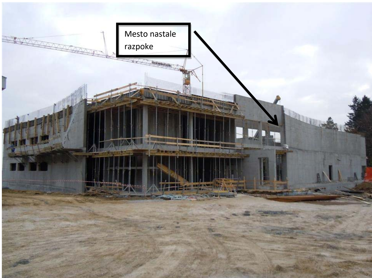
Fotografija športne dvorane v delu 14. marca 2012. Na fotografiji je označeno mesto nastale razpoke.
