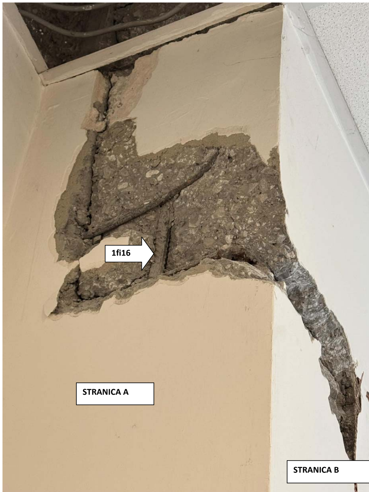
Slika 7: Pogled na stranico A/B – stik steber-nosilec. Na sredini poteka ena palica fi 16 ( poz. 1). Na stiku steber – nosilec je vidno U streme.
