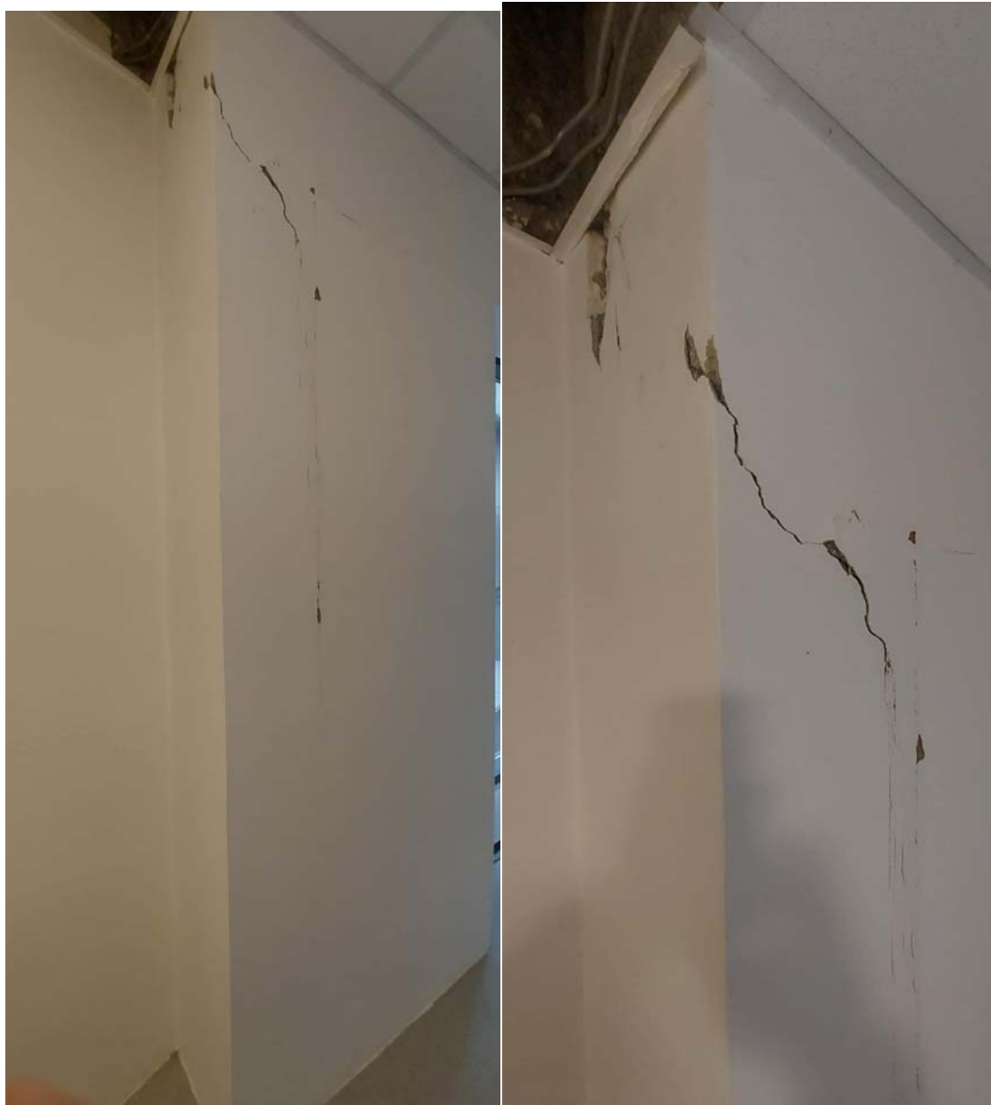
Slika 3 : Prikaz novonastale razpoke
